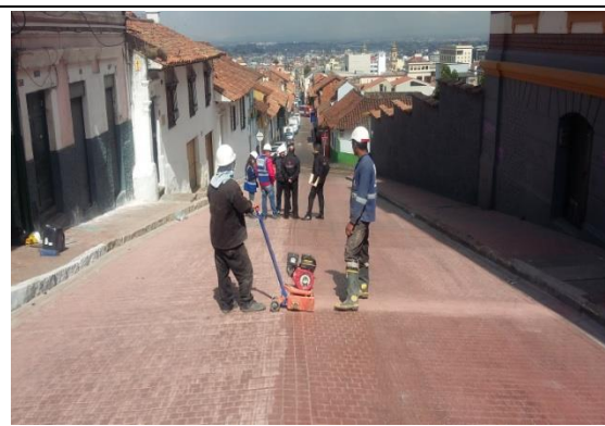
Foto No 2: se observa que la vía está siendo intervenida en la superficie de concreto rígido, rayado o micro-fresado.
